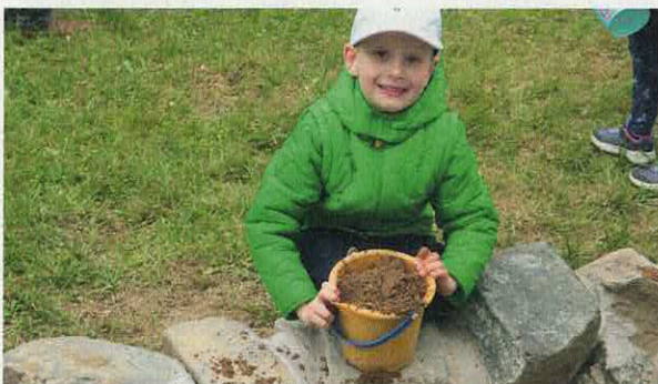
Auch die Kinder helfen dabei mit, das Loch zu befüllen.
