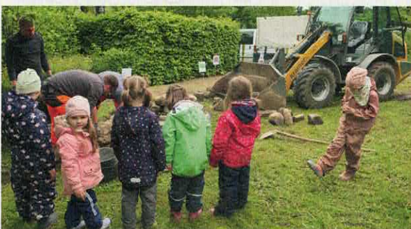
Die Baggerarbeiten waren ein Highlight für die Kinder.
